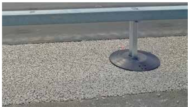
Nutzfläche mit REWADUR Bankettbeton
