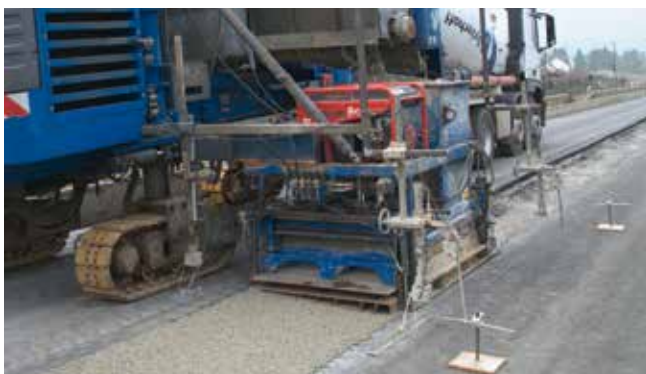
Einbau von REWADUR Bankettbeton
